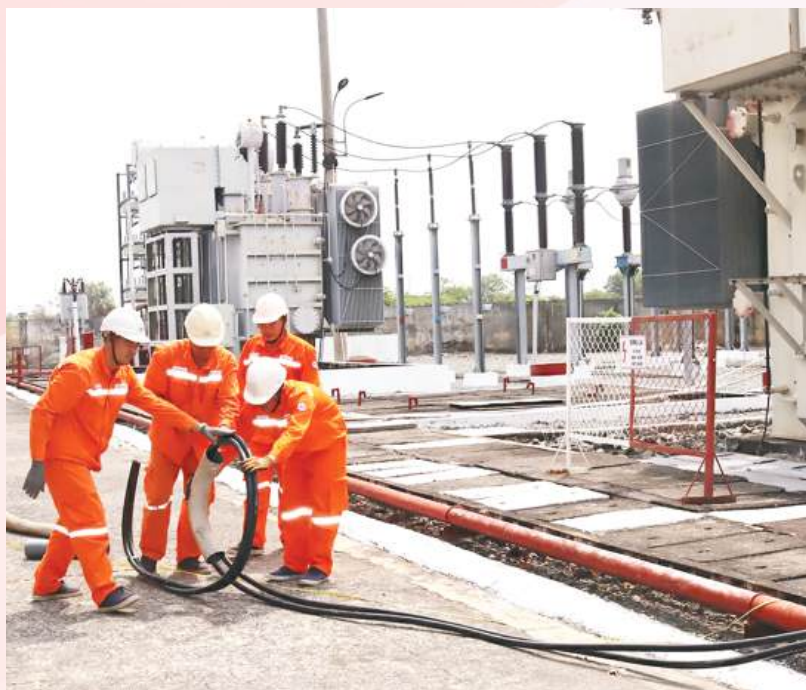
Công nhân điện lực Đồng Nai thực hiện thay thế, nâng cấp thiết bị Trạm biến áp 110kV Tân Mai
